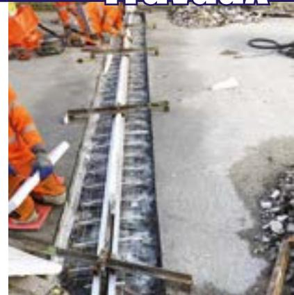
Travaux de joint de chaussée sur le Pont de l'A21, rue Danton
